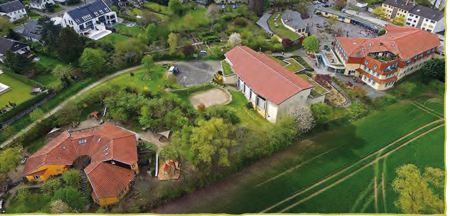
Die Freie Waldorfschule Haan-Gruiten aus der Luft.
